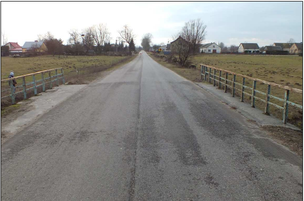
Rys. 2.2 Widok na obiekt od strony Myszała
