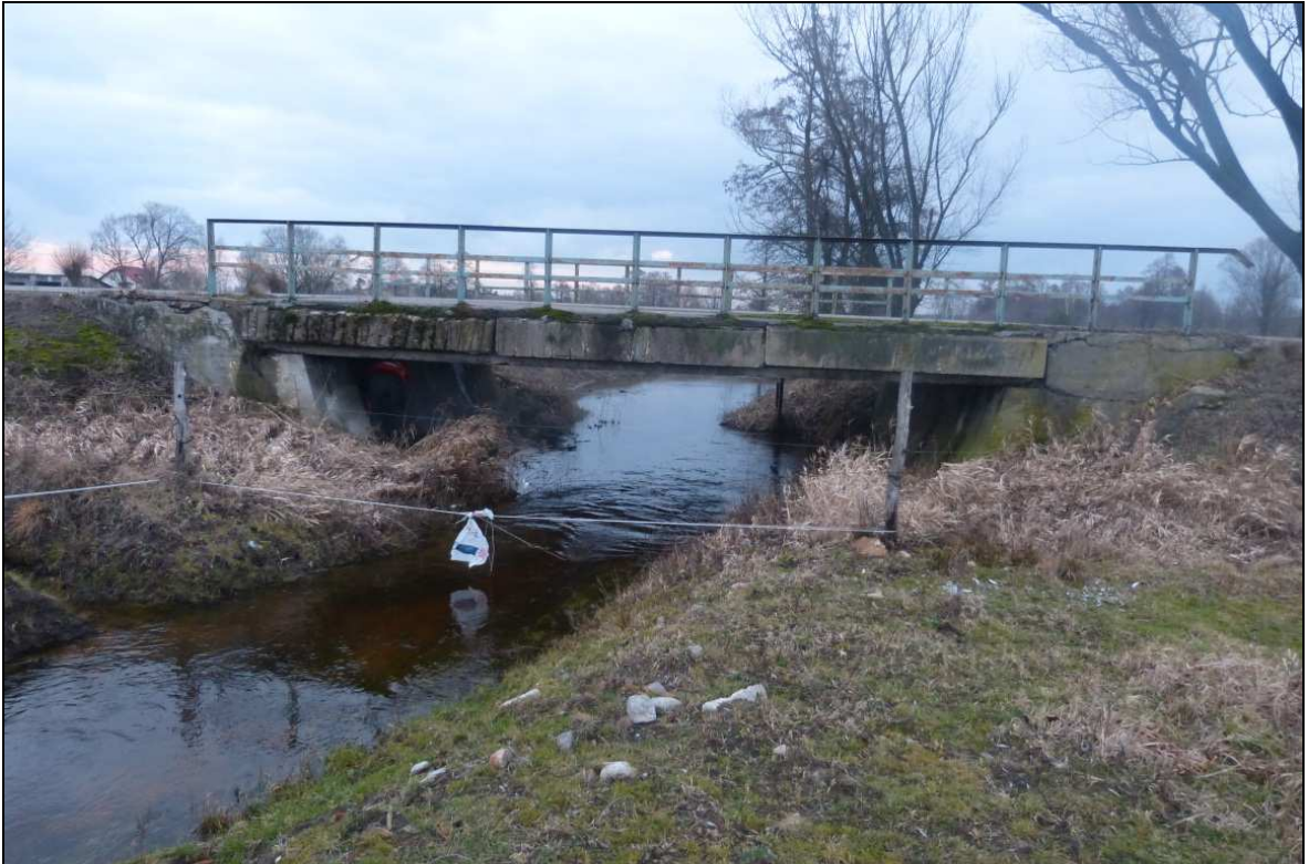
Rys. 2.1 Widok na obiekt od strony wody górnej
